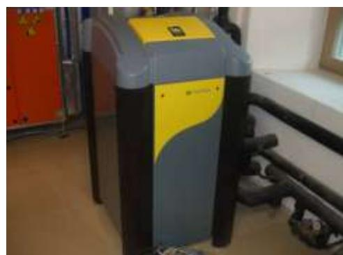
1.2.2. La scelta del progettista, circa il generatore di energia necessario per riscaldare, condizionare gli ambienti e integrare la produzione di acqua calda sanitaria, è ricaduta su una pompa di calore geotermica.
